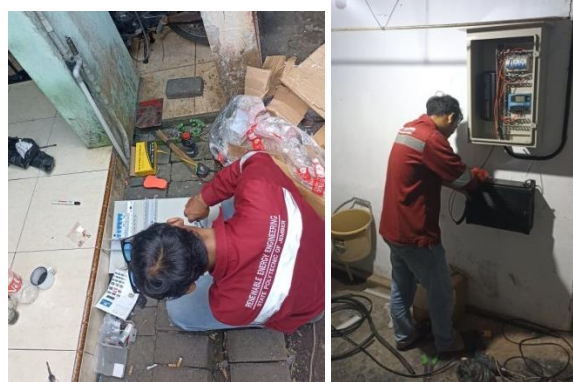
Gambar 5. Pemasangan instalasi PLTS
