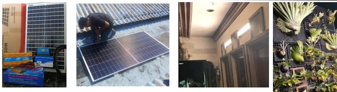
Gambar 4. Pemasangan Solar Panel dan Growlight Pada Mitra
